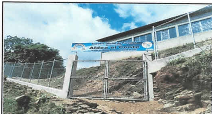
Foto 6: Instalación de portón de ingreso principal, finalizando con ello el proyecto de remozamiento.
