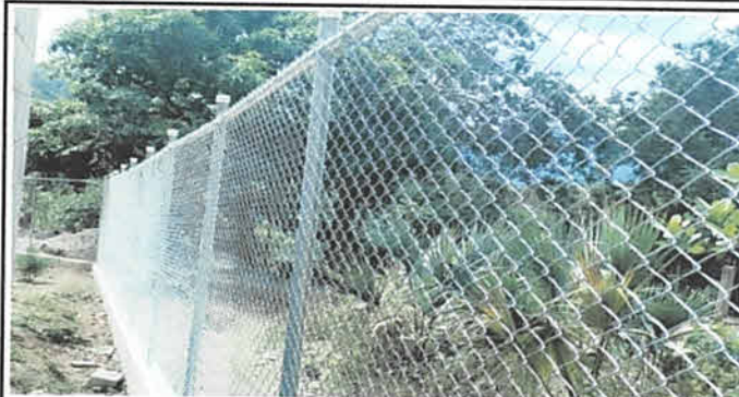
Foto Los postes y tubo travesaño es de tubo galvanizado para cerca de 1 1/2", con tapones de pvc para protección
