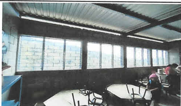
Foto 3: Todas las ventanas se encuentran ahora con aluminio y vidrio que dan la protección principalmente a la lluvia que ingresaba por esos espacios
