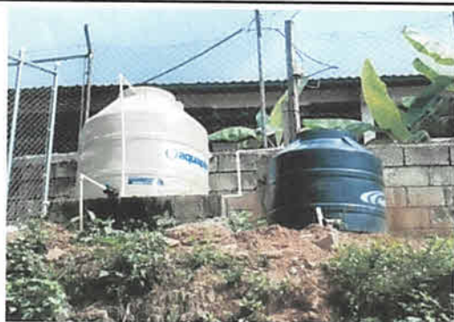
Foto 5: Se instaló el nuevo tinaco de 1,100 litros, dejando a la par el existente para una futura reparación y mejor aprovechamiento del recurso
