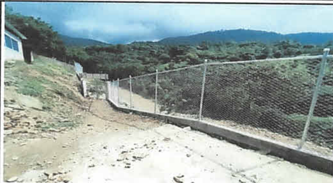
Foto1: Se completó la circulación con malla perimetral y base de concreto y block.
